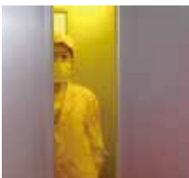
エアシャワー室。風で服についているホコリや髪の毛を落とす。
